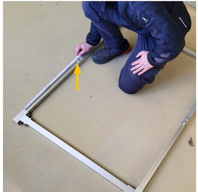
Länge überprüfen und Schrauben festziehen (49,5cm für Solarmodul EAS-S410)
