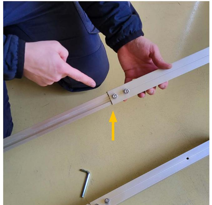
Modulauflagen an gekennzeichnetener Linie ausrichten und fixieren (entspricht der Maße für Solarmodul EAS-S410)
