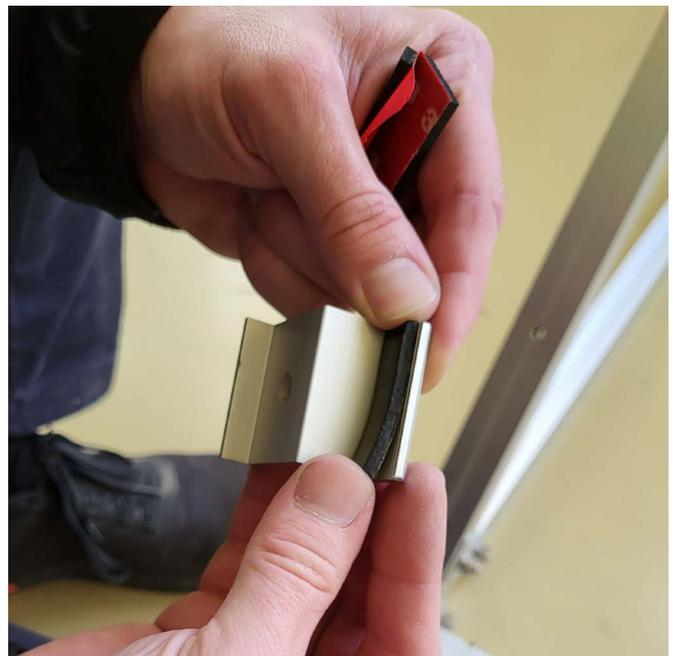
Dem Solarmodul beigefügte Gummisicherungen an Modulklemmen gemäß Foto anbringen
