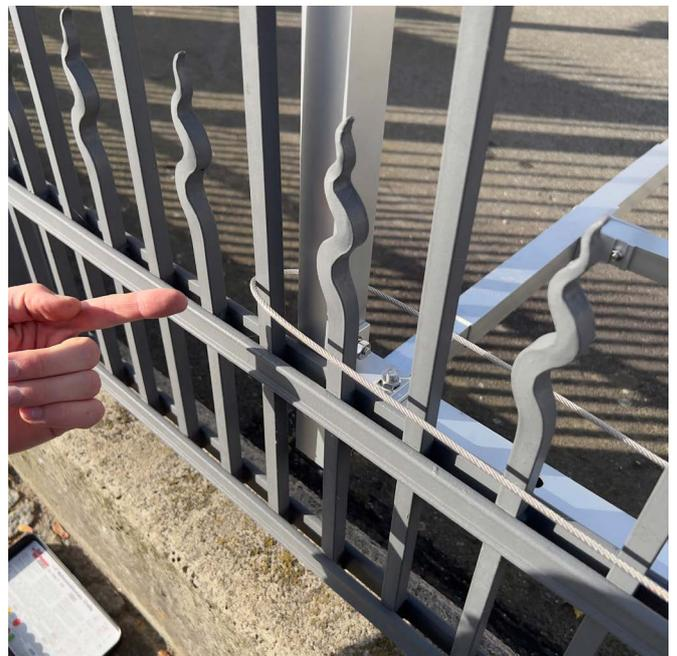
Mittels Sicherungsseil Modulgestell gemäß Fotos am Balkon befestigen
