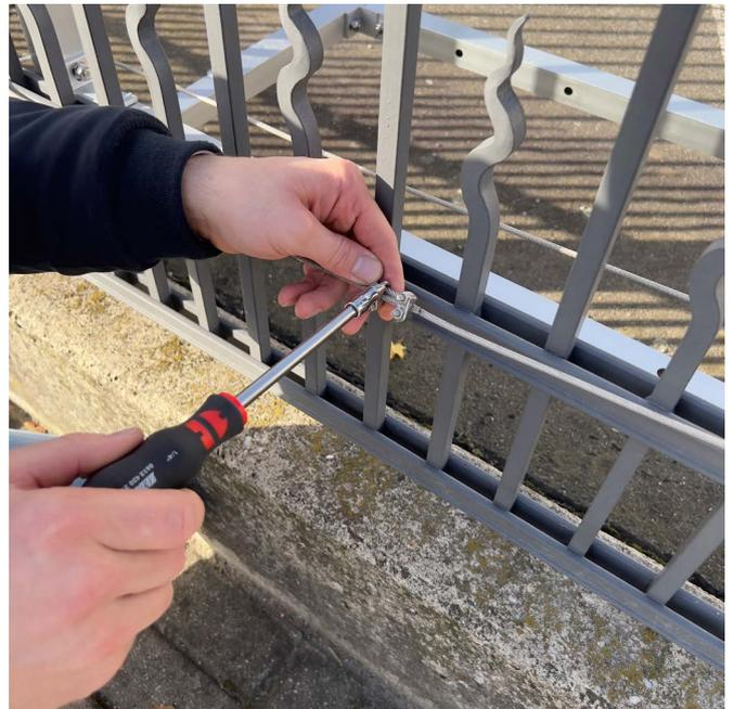
Sicherungsseil mittels Stahlseilverbinder befestigen und festziehen
