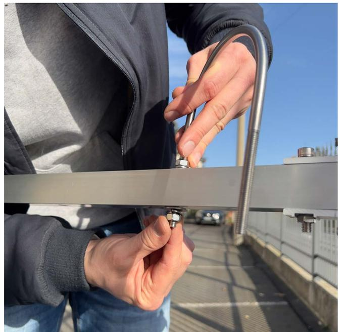
Bügelchellen gemäß Foto am oberen Rahmen des Modulgestells anbringen und festziehen
