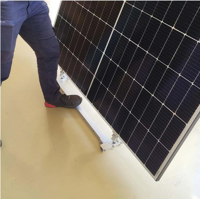
Solarmodul unten einlegen
